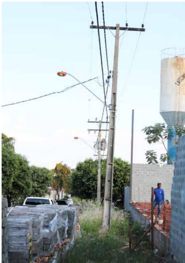
**Poste de energia está inclinado para dentro do terreno, impedindo que a parede seja erguida, pelo risco de acidentes**
