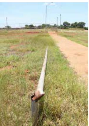
**Poste derrubado, padrão de energia arrancado e braço da luminária quebrado**
