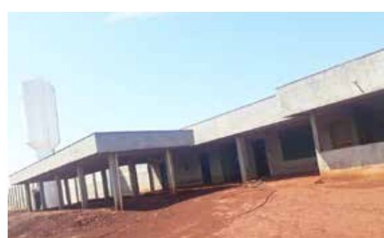
Obras do Centro de Atendimento Socioeducativo (CASE) foram retomadas pelo governo
