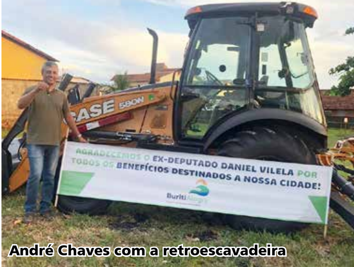
André Chaves com a retroscavadeira
