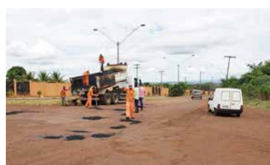
Modesto de Carvalho: serviço de tapa-buracos e a partir de abril terá início a reconstrução da GO-206
