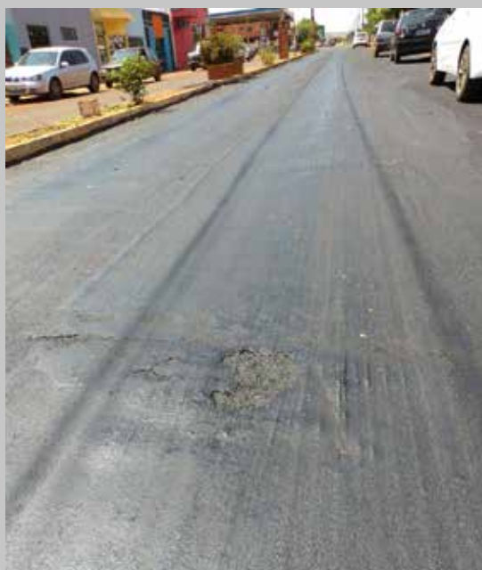
Trecho recapeado da Av. Osmar José Garcia: serviço de baixa qualidade e desperdício de material levou a Prefeitura a interditar a via
