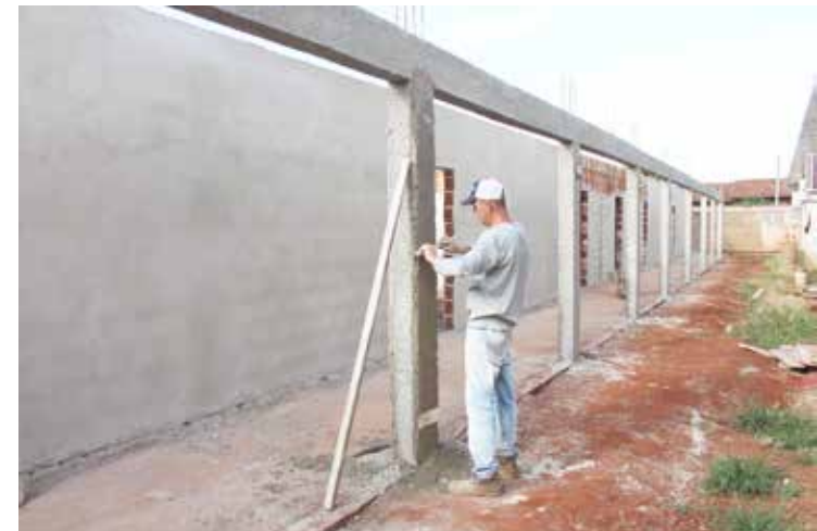
Obras na Escola Municipal Peixoto da Silveira
