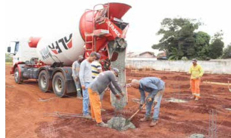
Obras na Escola Municipal Maria Leopoldina de Carvalho
