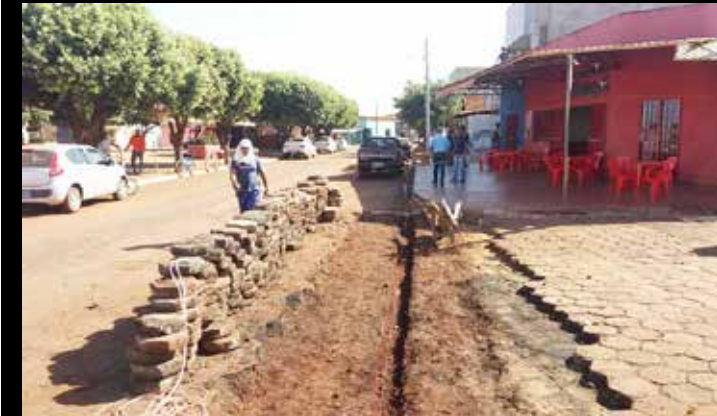
Obras em andamento em vários setores
