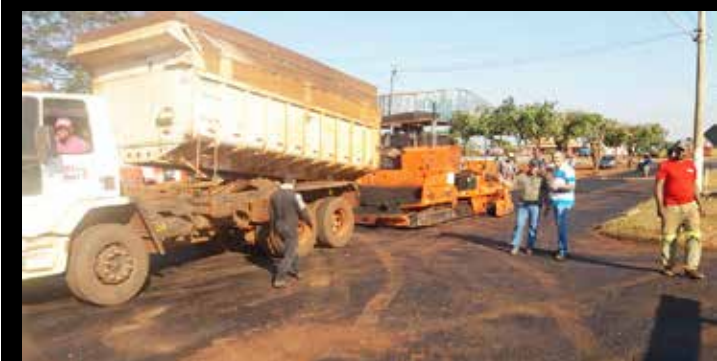
Obras em andamento em vários setores
