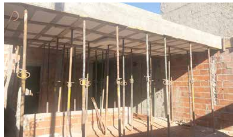
Andamento da construção da sede da Delegacia
