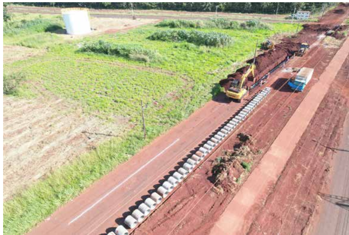
Construção de rede pluvial na Av. Dr. Celso Maeda
