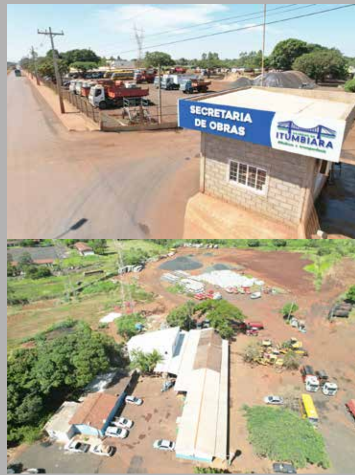
Guarita na entrada do Obras (Usina de Asfalto) e visão do pátio, com prédio do almoxarifado
