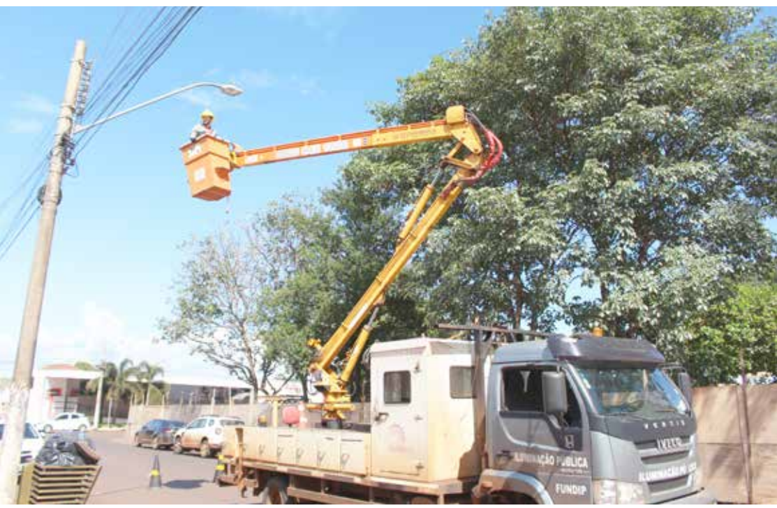
Equipe de iluminação Pública faz troca de lâmpadas na região da Praça São Sebastião
