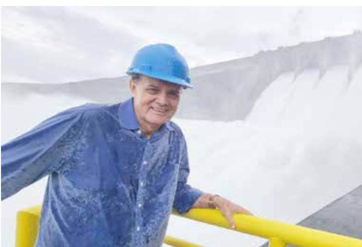
Prefeito Dione Araújo acompanhou a abertura das comportas da Usina de Itumbiara (Furnas) na tarde de terça, 14 de março
