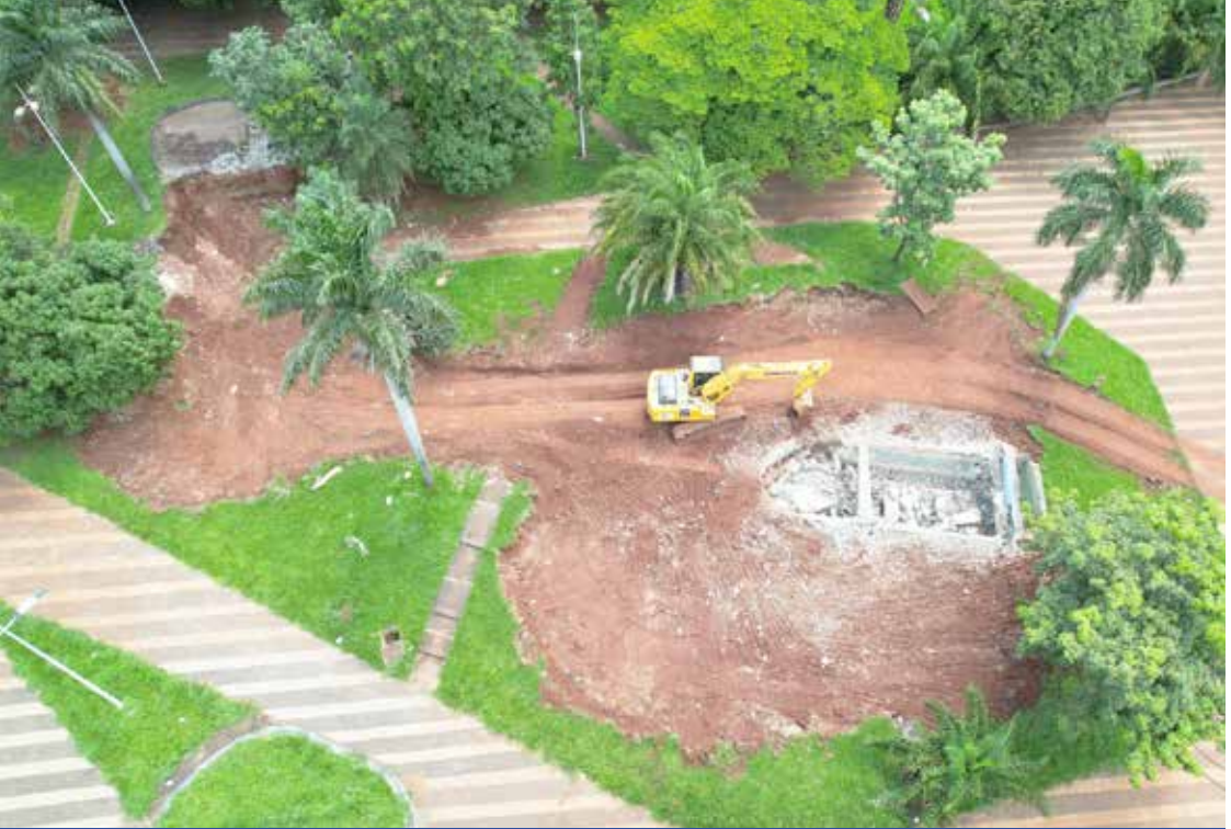
PRAÇA SEBASTIÃO XAVIER Início das obras de requalificação da Praça Sebastião Xavier. Mais de R$ 4 milhões em investimento
