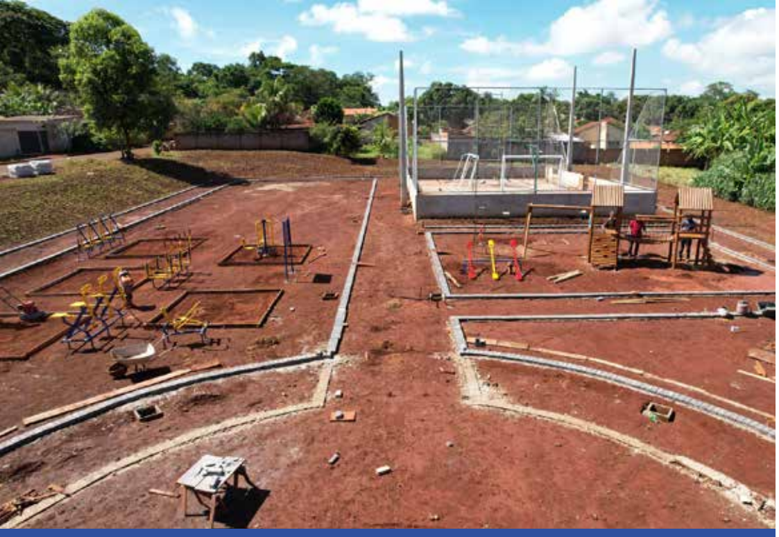
PRAÇA NO SARANDI Andamento das obras de construção da Praça no distrito de Sarandi, com quadra esportiva, parquinho para crianças e academia de saúde
