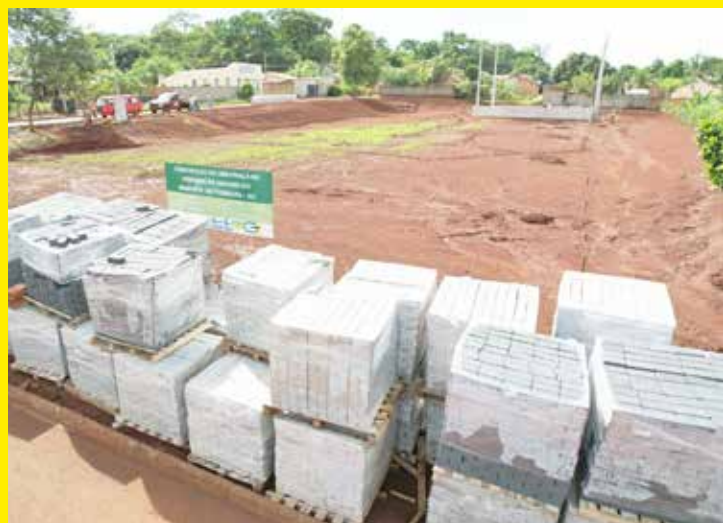
Material para construção da Praça no distrito de Sarandi
