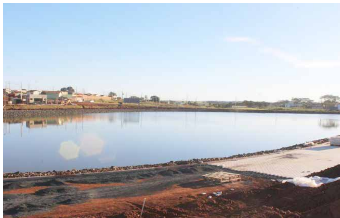
Prefeita Renata Borges está investindo mais de R$ 3 milhões na obra, com recursos próprios. 40% das obras estão prontas e a previsão é entregar em quatro meses
