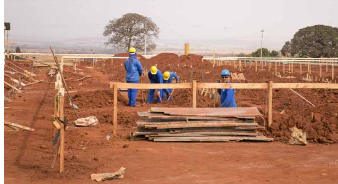
Operários trabalhando na construção da Escola de 12 salas de aula
