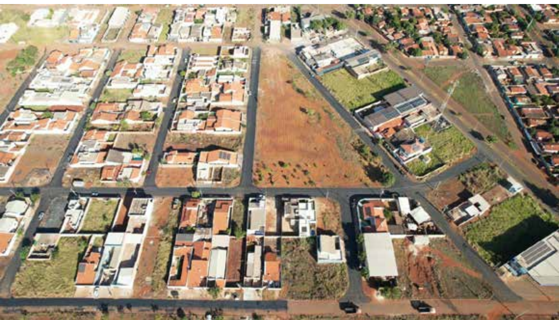
Pavimentação de ruas no Bairro Alto do Trindade
