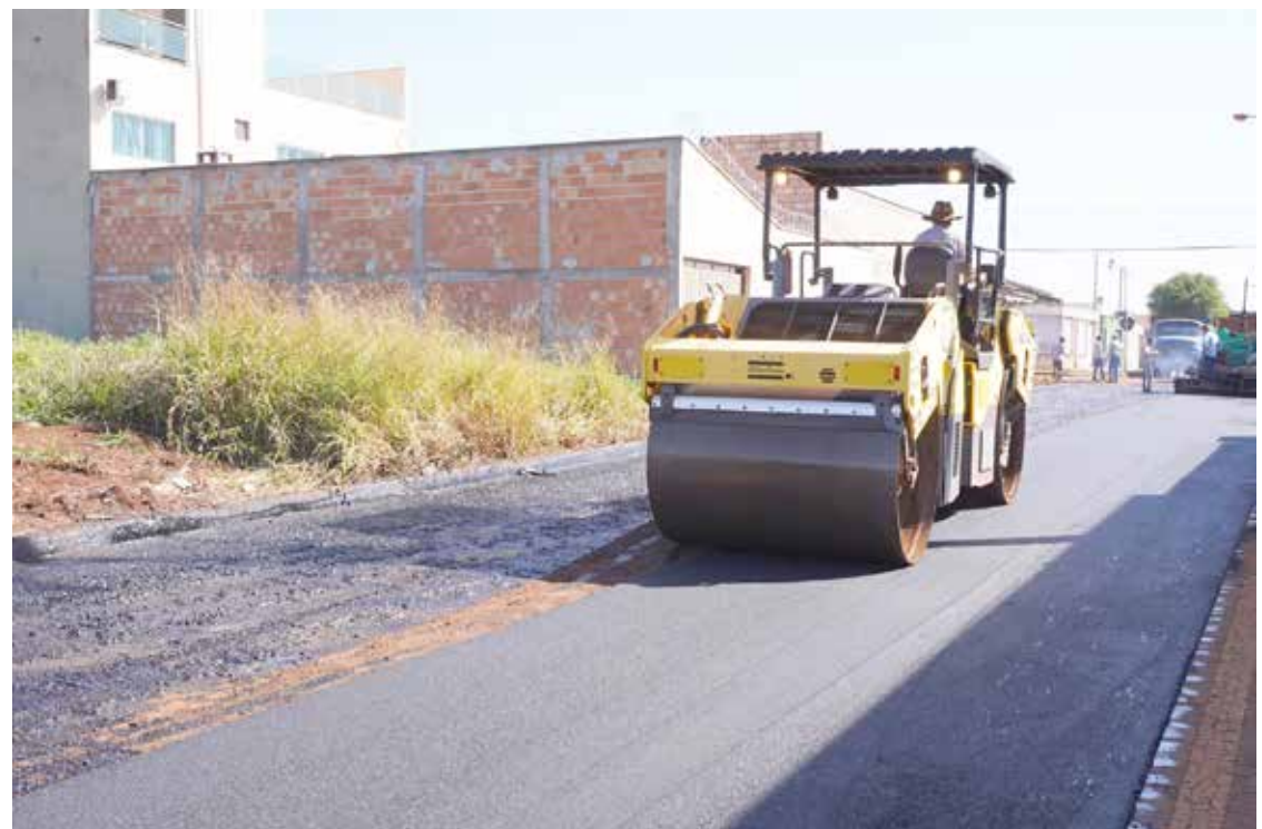
Asfalto de qualidade, com CBUQ, sendo aplicado nas ruas do setor
