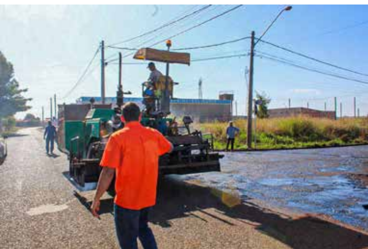
Neto Karfan na vistoria do serviço de asfalto
