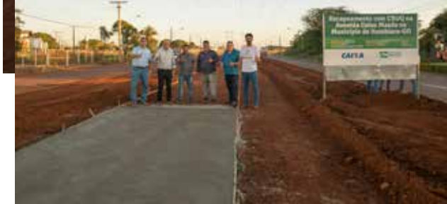
Prefeito Dione Araújo conferindo a construção da calçada na Av. Dr. Celso Maeda
