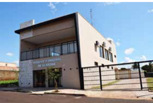
Construção do Arquivo Municipal
