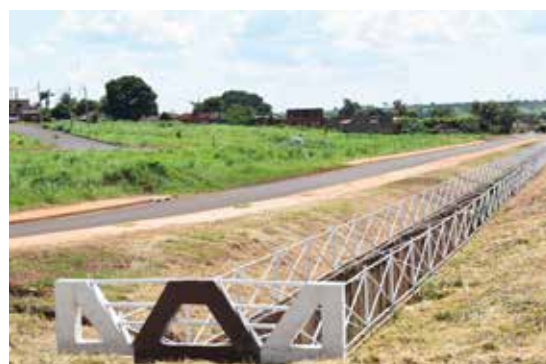
Canalização do Córrego Alvorada
