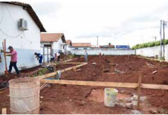
Construção da sede da Secretaria Municipal da Educação
