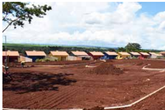
Construção de praça no Bairro Madri
