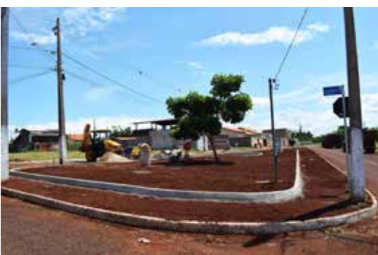
Construção de praça no Bairro Palmeiras
