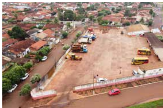
Pavimentação do Centro de Serviços
