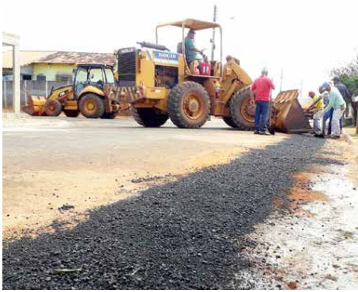
Recuperação do asfalto nas ruas da Vila Matilde
