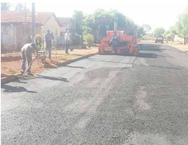
Recapeamento em andamento no Bairro José Inácio
