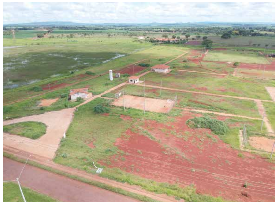
Parque Beija Flor é a obra parada mais antiga da Prefeitura, com 16 anos. Gestão do prefeito Dione Araújo direcionou recursos para recuperar a parte danificada e em acordo com MP Estadual e Federal e Caixa, concluir a obra
