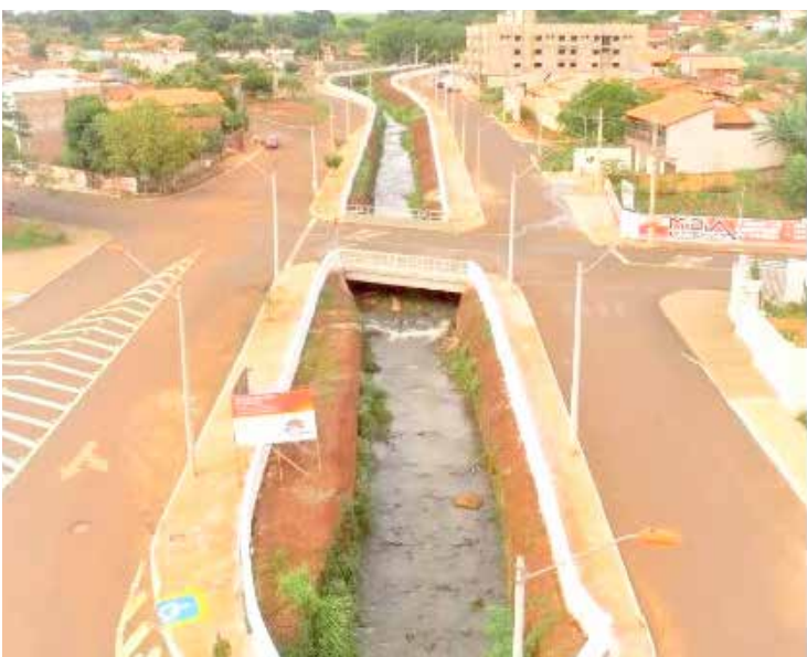
CANALIZAÇÃO DO CÓRREGO ÁGUA SUJA E PROLONGAMENTO DA AV. ROGELINA MARIA
