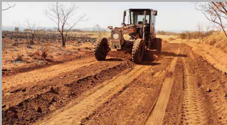
Parceria entre produtores e a Prefeitura na recuperação das estradas
