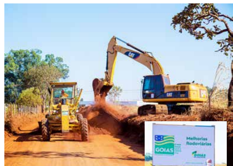
Dione acompanha o início das obras de recuperação próximo à Cerâmica Souza/AlcaFoods
