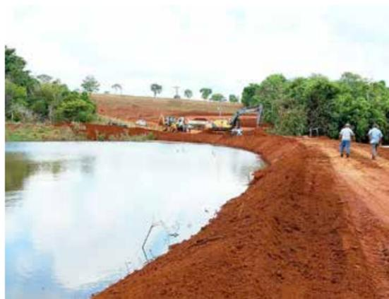
A Prefeitura de Panamá reestruturou o sistema de abastecimento de água, com ativação de dois poços artesianos que estavam abandonados. Foram instaladas novas bombas, encanamento, fiações, painéis de controle e reforço na represa de captação para permitir aumento da oferta de água potável.
